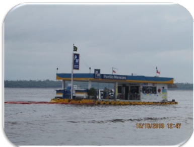
CONJUNTO DE FOTO 1: Vista da Instalação "PONTÃO MENEZES" fundeada no Rio Negro/AM
